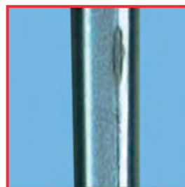
Контактная коррозия: нержавеющая сталь/латунь
