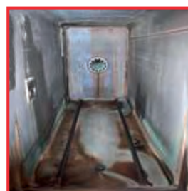
Слева - держатель фильтров с частичной коррозией
