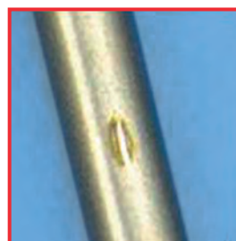
Контактная коррозия: нержавеющая сталь/нержавеющая сталь
